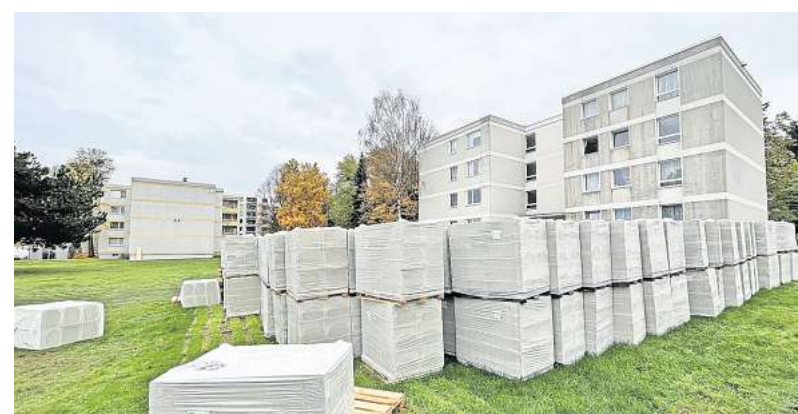
Die Bauarbeiten laufen: Die Adler Group saniert ihre Wohnungen in Grone. Verkaufen will sie an die LEG Immobilien.
